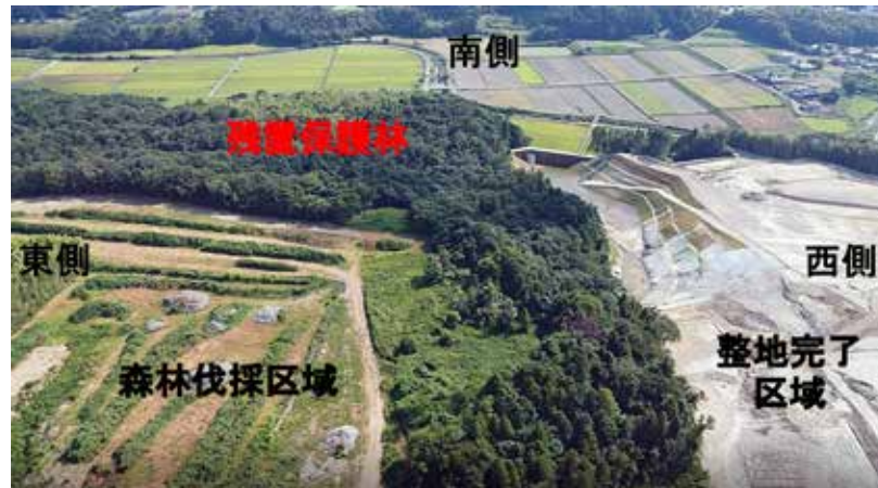
足見川メガソーラー建設地 東エリア 撮影：三曾田 明
