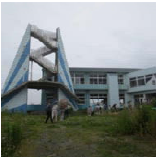
請戸小学校跡
